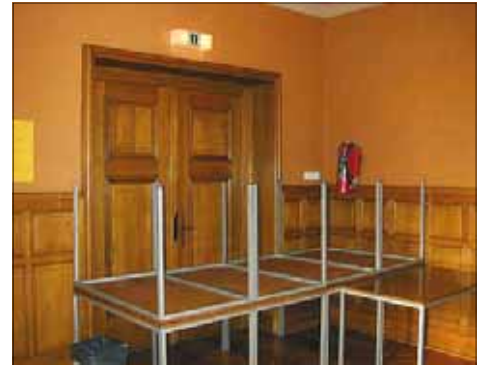
Zugestellter Notausgang und Feuerlöscher
